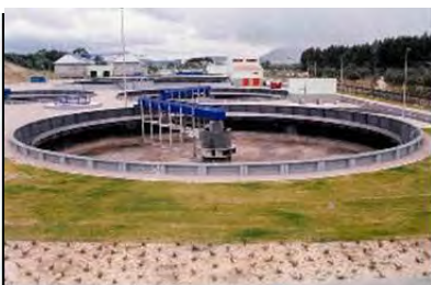
Tanques de decantação onde os flocos (hidróxido de alumínio + impurezas) depositam-se no fundo formando uma camada de lodo
