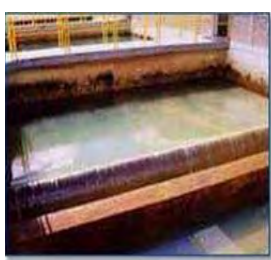
Tanques de decantação onde os flocos (hidróxido de alumínio + impurezas) depositam-se no fundo formando uma camada de lodo
